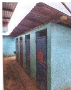
Foto 2: Mantenimiento a estructura (Lijado, cambio de tubo, cepillado sujeciones, aplicaciones de pintura)
