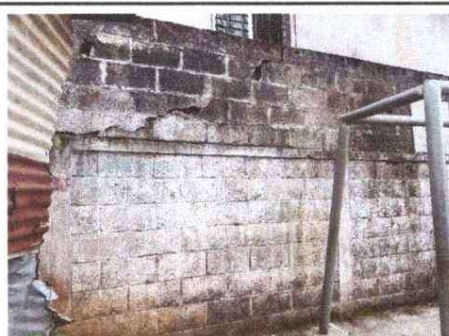
Foto 6: Reparación de muro perimetral de block con tubo Hg y malla, soleras intermedias y columnas.
