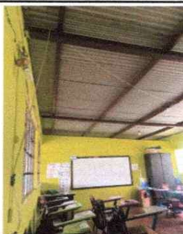
Foto 11: Sustrucion de plafoneras
