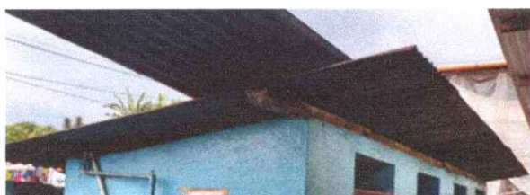
Foto 1: Sustrucción de lamina troquelada aluzinc calibre 26 en bateria de baños
