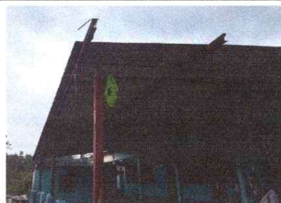
Foto 4: Sustrucción de canales de metal en el patio del instituto
